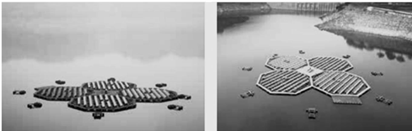
Рис. 2. Плавающая СФЭС с системой слежения за Солнцем, расположенная в водохранилище Хапчон, Республика Корея [9, 10]
