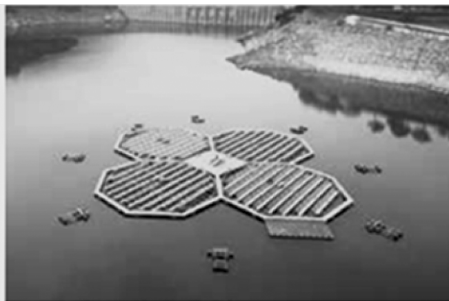
Рис. 2. Плавучая СФЭС с системой слежения за Солнцем, расположенная в водохранилище Хапчон, Республика Корея [9, 10]
