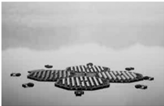
Рис. 2. Плавучая СФЭС с системой слежения за Солнцем, расположенная в водохранилище Хапчон, Республика Корея [9, 10]
