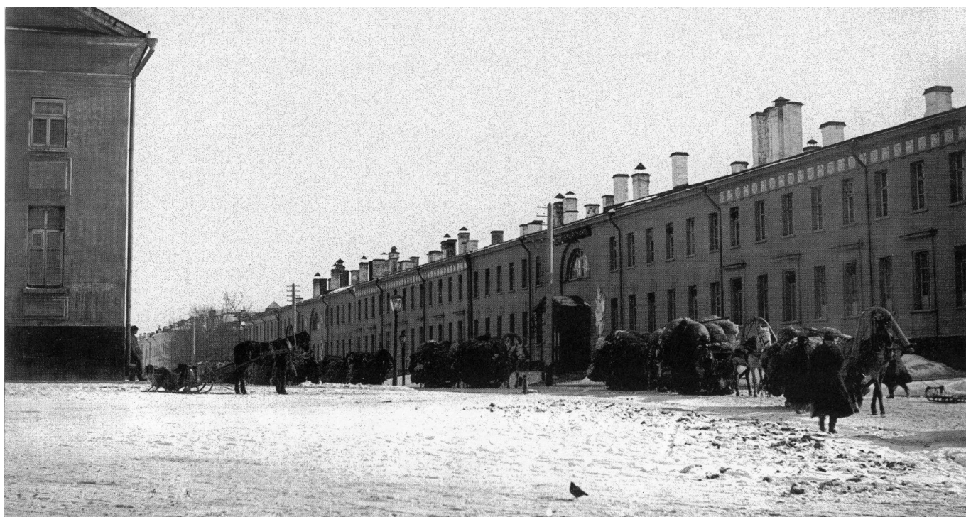
Рис. 2. Здание казарм Алексеевского военного училища — Московского пехотного юнкерского училища. Красноказарменная улица. 1900–1905 гг. [5].
