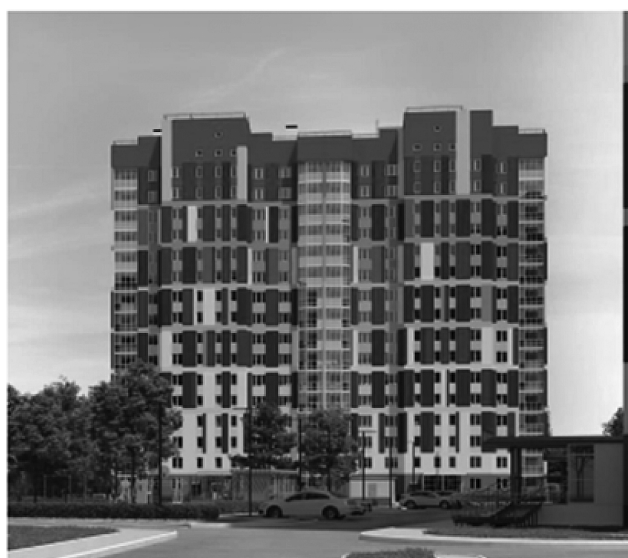
Рис. 6. Здание, спроектированное с использованием BIM-технологии
