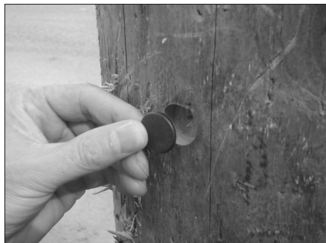
Рис. 4. Внедрение RFID метки в тело опоры
