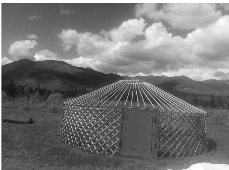
Рис. 2. Деревянный каркас юрты
