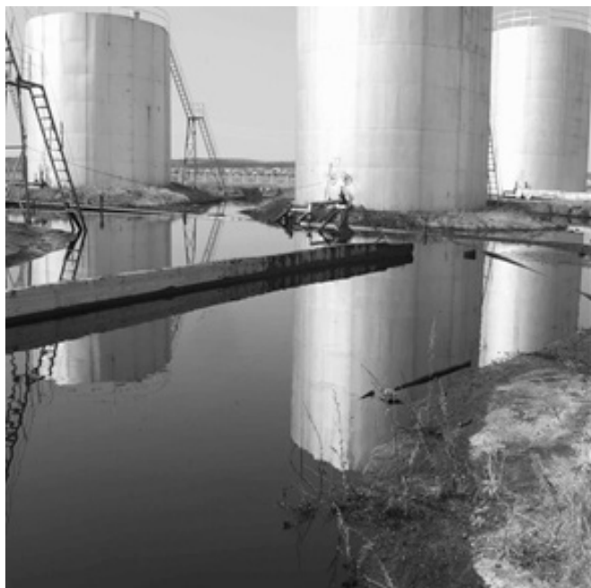
Рис. 1. Место аварийного разлива нефти
